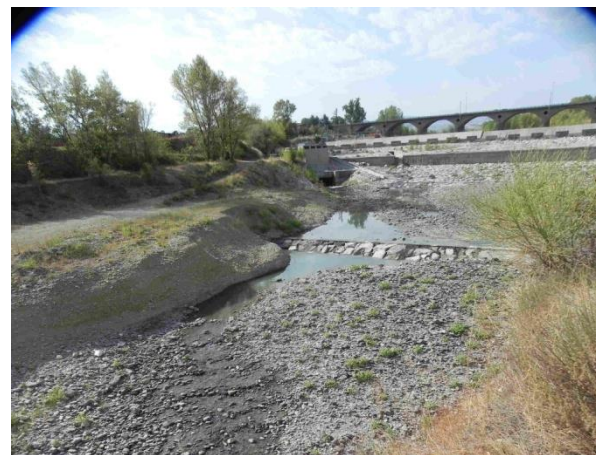
Caso 4) Presenza di manufatto intercettatore all'estremità di monte - F.SECCHIA_21
